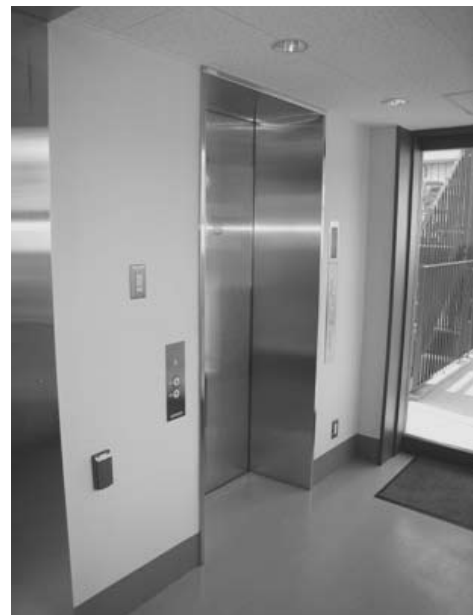
写真14 昇降機設備11人乗り (身体障害者仕様(車椅子・視覚障害者))
