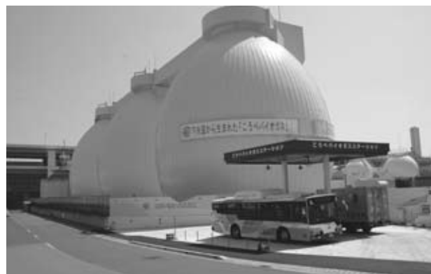
バイオガス供給ステーション
