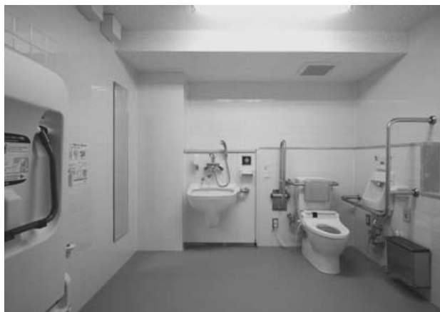
写真4 多目的(だれでも)トイレ(オストメイト対応)
