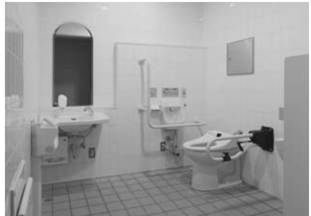
写真5 オストメイト対応トイレ
