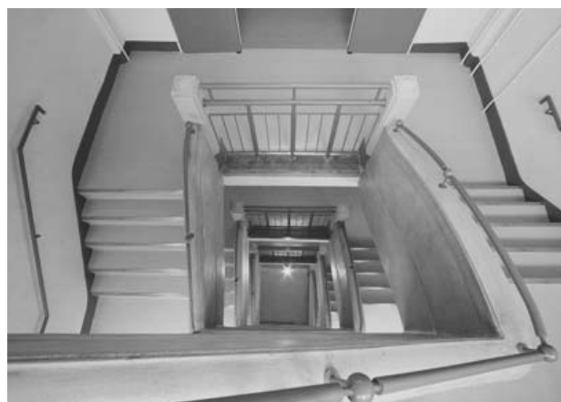
写真3 中央階段より
