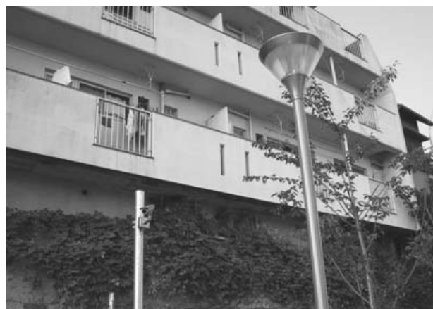
写真8 外灯・防犯カメラ設備
