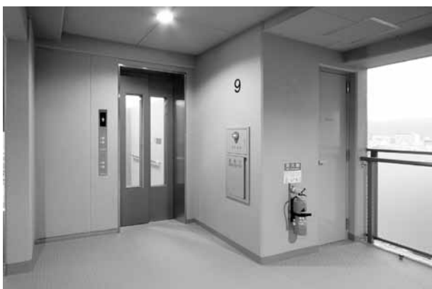
写真8 住宅用基準階 EV ホール
