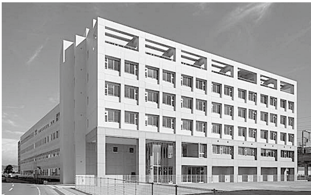
写真1 ものづくり大学校（仮称）教育研修施設 外観
