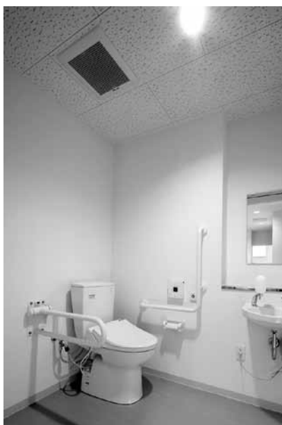
写真7 2階集会室便所
