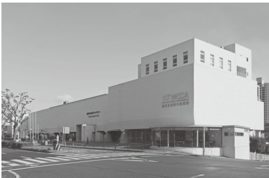
【北西からみた外観（完成後）】
