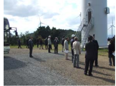
風力発電機の下部
