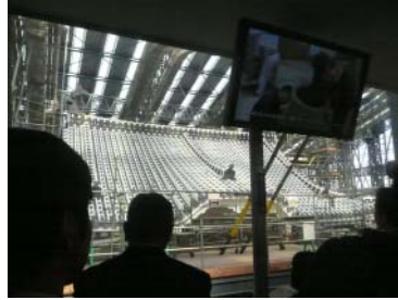
大天守保存修理工事
