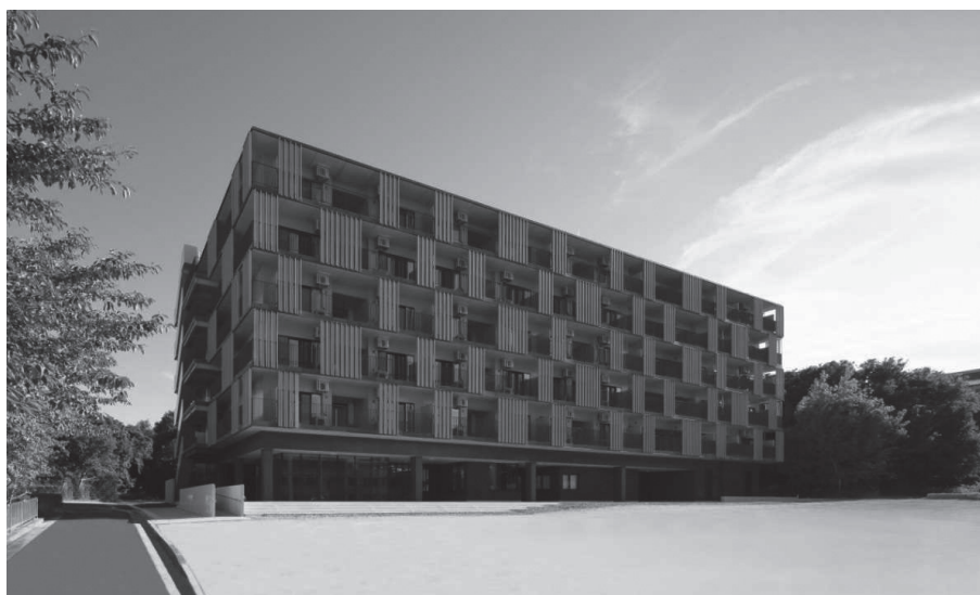
【兵庫県立大学国際学生寮 外観（完成後）】
