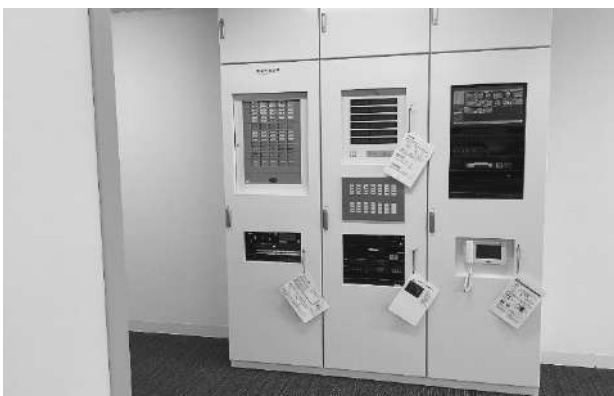
【体育館兼特別教室棟1階事務室】
