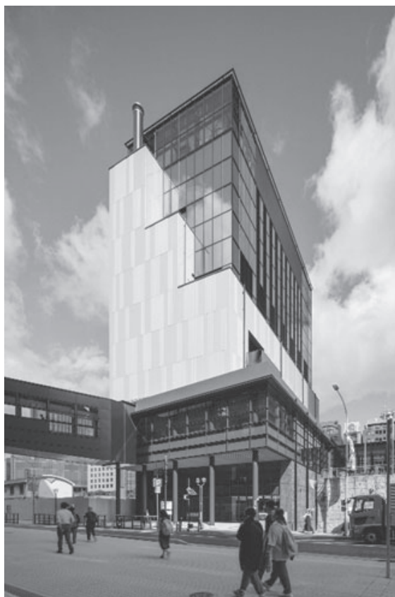
建物外観（南西面）
