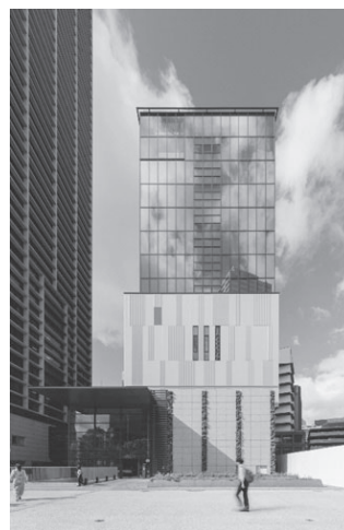
建物外観（東面）
