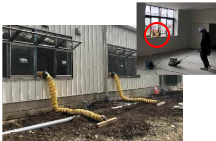
送風機を稼働し、埃を外部へ排出
