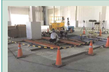
工事エリアの区画を設定して作業
