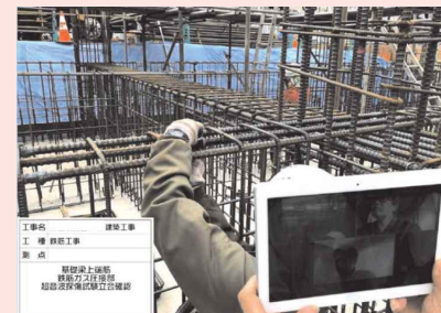
Webカメラを利用した遠隔検査
