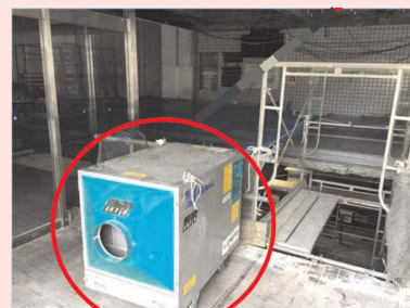
集塵機を設置し室内の換気を実施
