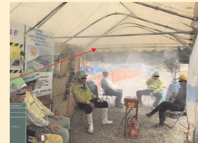
屋外休憩所にドライミスト発生装置等を設置
