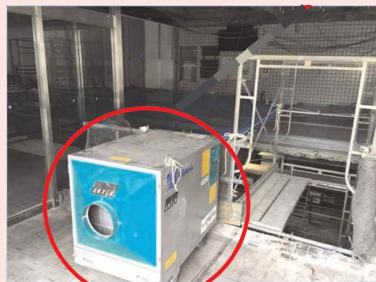
集塵機を設置し室内の換気を実施
