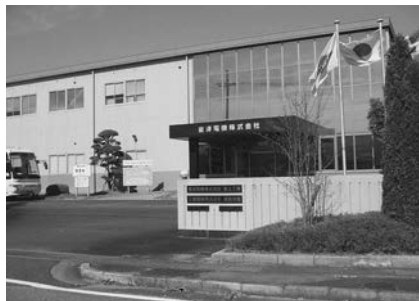
東洋電機(株)氷上工場
