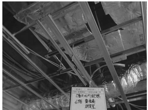
【天井裏配線状況】
