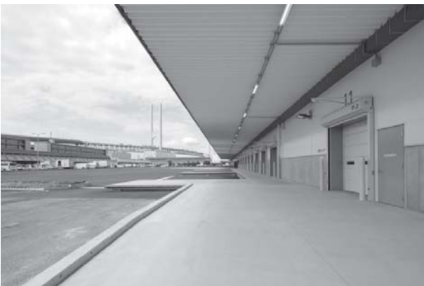
建物外観（プラットホーム）
