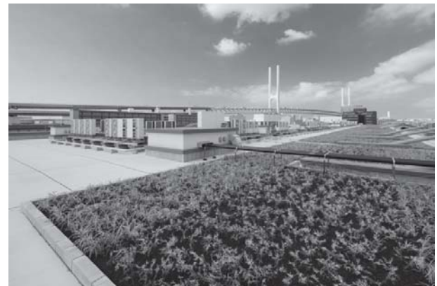
室外機置場・屋上緑化
