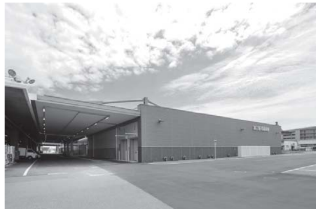
建物外観（南西から）
