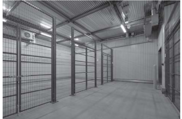
水産物部加工場（冷凍庫）
