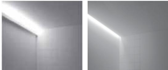
【コーブ照明（天井面） コーニス照明（壁面）】
