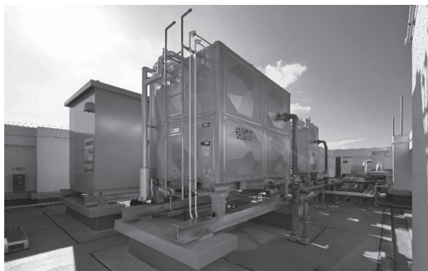
屋上設備置場
