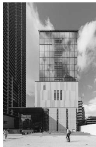
建物外観（東面）
