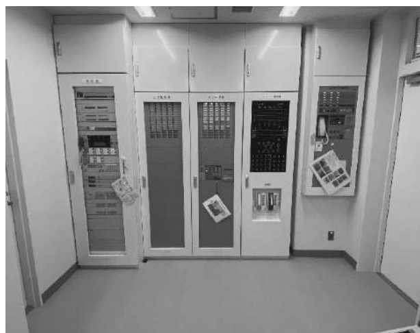
1階 中央管理室
