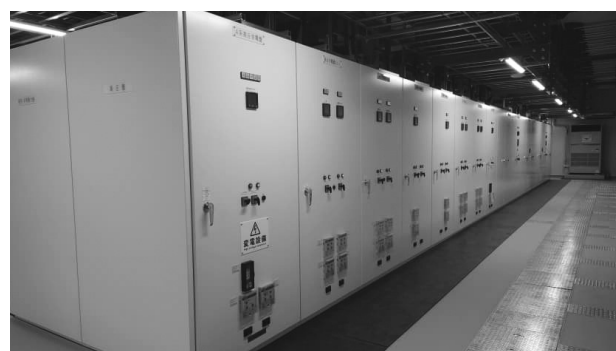
【4階 第1電気室 高圧配電盤】
